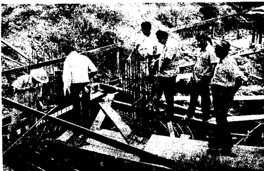
Controle van de bewapening van de „Minaret-fundering”. Van rechts naar links op de foto de heren: M.A. POESA (aannemer); Ir. N. ATAPELLAH (voorz. Bouwcommissie); Ir. E. NOERMOHAMED en Ir. G.D. SOERDJOESING (techn. Adviseurs).
